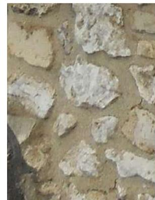
à base de ciment. Ces joints sont souvent dégradés et ne remplissent plus leurs fonctions d'étanchéité. La pierre est attaquée par l'humidité, et après avoir perdu son calcin (couche de protection formée par les sels minéraux cristallisés en surface), commence à se déliter.
