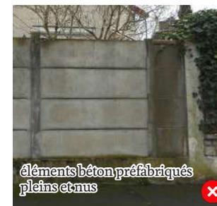
éléments béton préfabriqués pleins et nus
