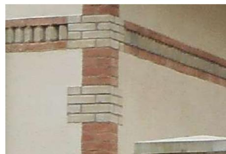
Chaînage d'angle en briques
