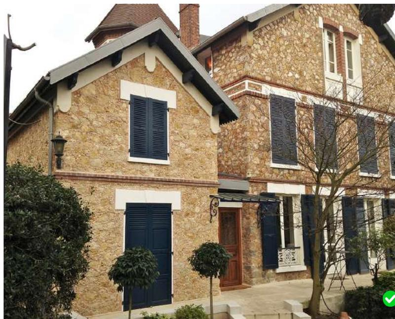
Reprise des matériaux, modénatures et teintes des occultants existants dans l'extension. Mise en oeuvre et finition traditionnelle réaliste.
